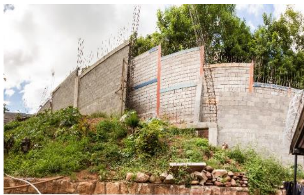
Levantamiento del muro perimetral CP Sagrado Corazón, 2015
