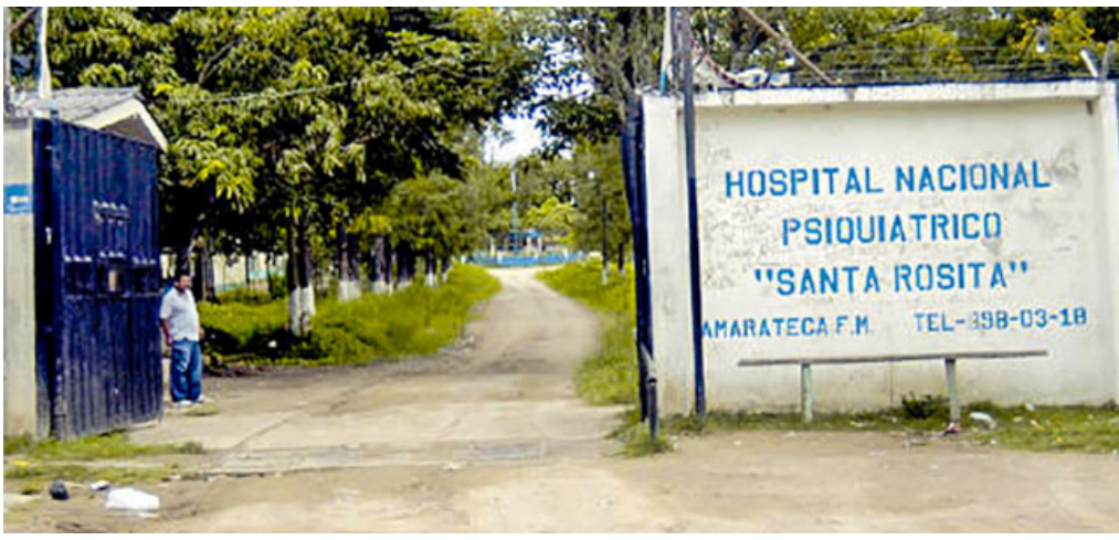
Entrada al hospital Santa Rosita.
